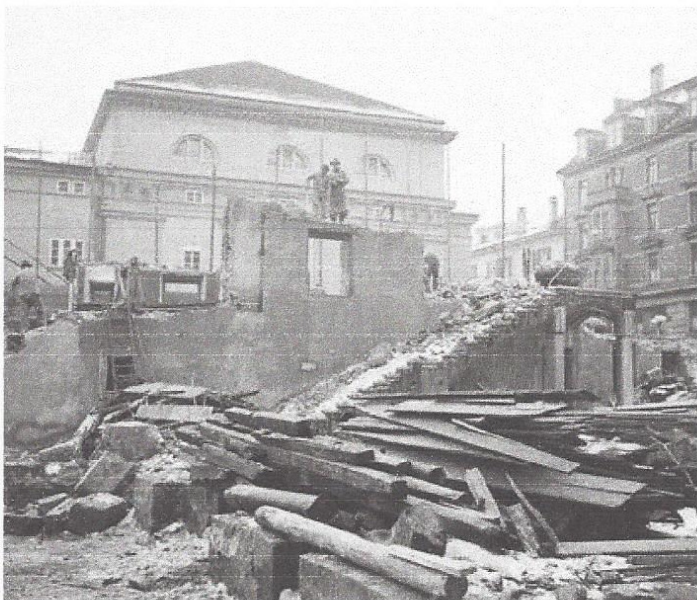
Blick auf die Abbrucharbeiten im Februar 1949. Im Hintergrund ist das Theater zu sehen.
