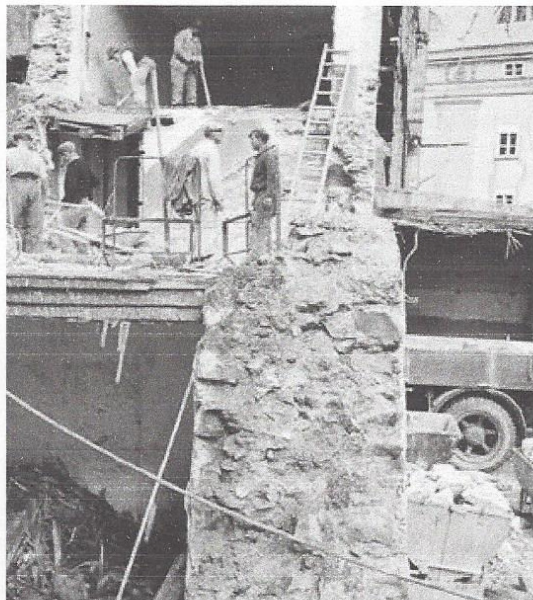
Bild von den Abbrucharbeiten.
